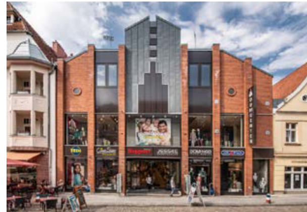
Abbildung 2 Domcenter Greifswald: Auffrischung und Öffnung der Fassade
